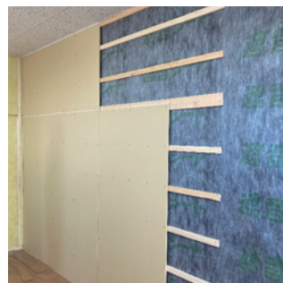
石膏ボードを貼付
