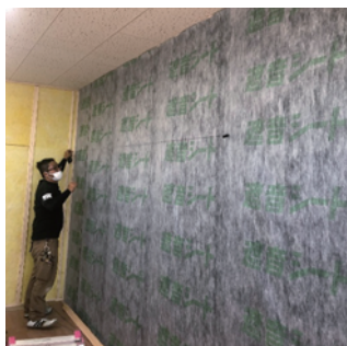
壁全面に貼付
